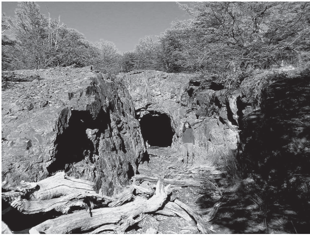
Figura 2. Vista de la bocamina correspondiente a la escombrera estudiada
