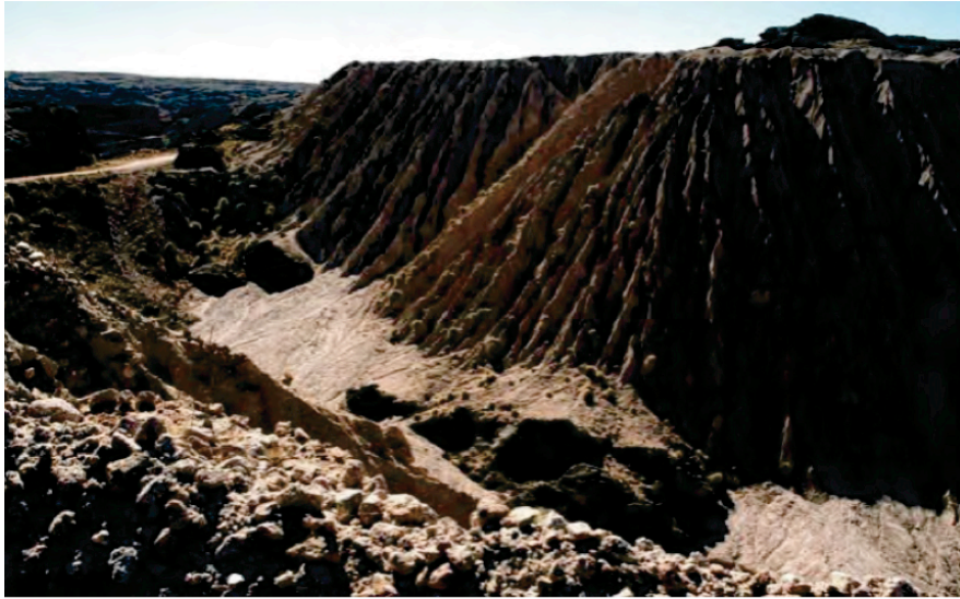
Excavaciones y pilas en Los Gigantes. Fuente: diario La Voz del Interior
