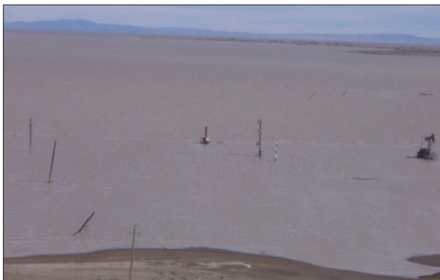
Foto 15: Vista panorámica donde se observan instalaciones inundadas al 02/11/07
