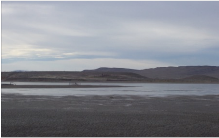
Foto 9: Instalaciones observadas al descender el nivel del lago
