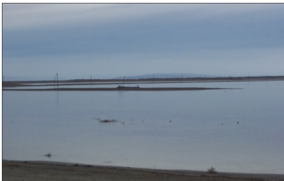
Foto 1: Instalaciones petroleras. Nótese disminución del nivel del lago con respecto a la visita anterior.
